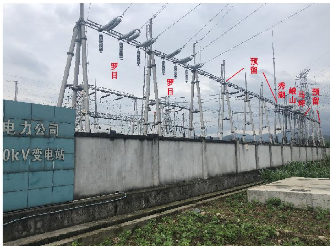
图 2-3 间隔扩建处现场环境图
