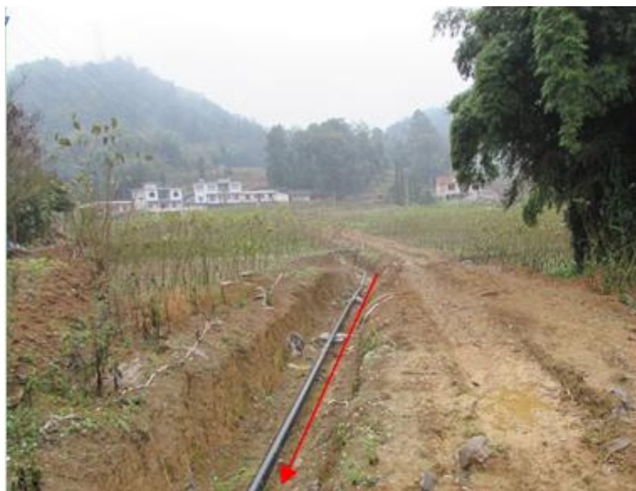
图 3.1-4 国内管沟开挖及布管实景图
