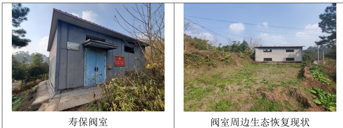
图 2.2-2 寿保阀室现场情况
