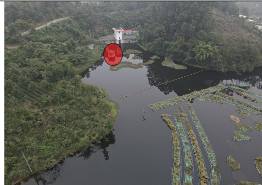
三岔河水库取水口
