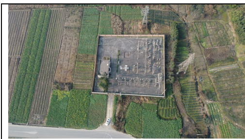
35kV 变电站现状
