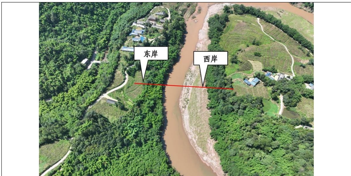
龙溪河穿越区地貌
