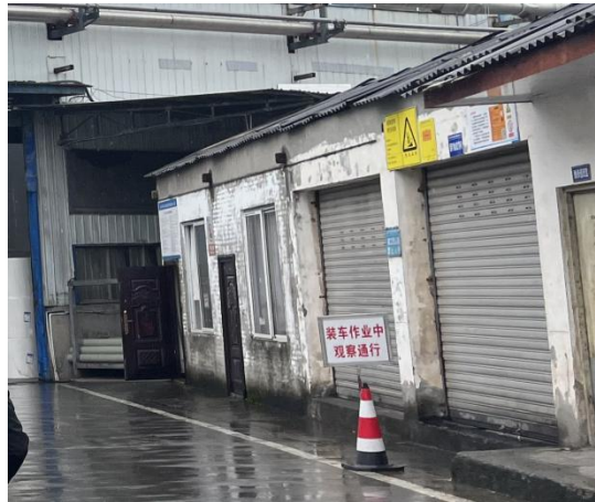
图 5 1#厂区危废暂存间
